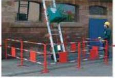
Pour la sécurité du personnel de chantier, la zone dangereuse doit impérativement être délimitée par un dispositif matériel lors de l'utilisation de nos monte-matériaux. Pour des barrières, nous consulter.
