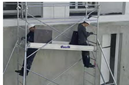
Plancher aluminium/bois ALTO à double trappe : risque de chute maîtrisé.
