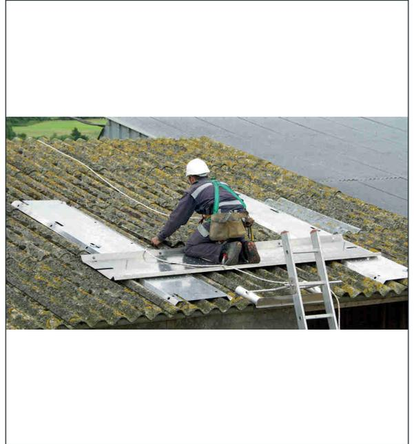
*Le **plancher securiplac** en aluminium spécial toiture fibres ciment à été conçu pour optimiser la sécurité des intervenants sur ce type de toiture.*
