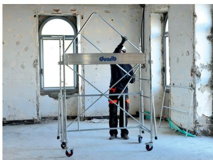
I parapetti sono installati da terra. L'operatore accede a un livello di lavoro totalmente sicuro.
